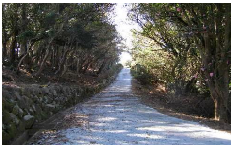
朝熊山頂・散歩道の舗装と排水補修
